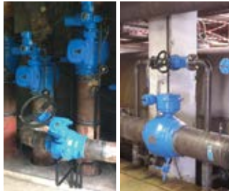
Zasilanie i powrót Odcięcie kotłów
